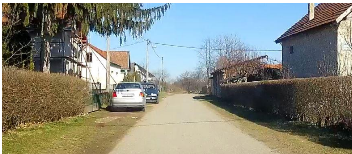
Slika 2. Postojeće stanje prometnice
