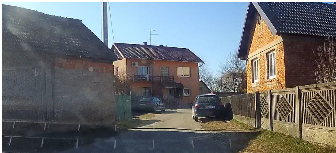
Slika 2. Postojeće stanje prometnice
